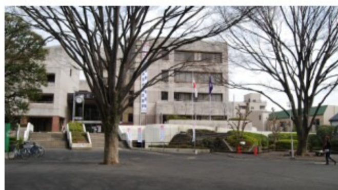
大きな揺れを感じた狛江市役所。新年度予算では市庁舎の耐震改修設計と写真右手の所への防災センター整備の設計が行われる。2012年度から2年間で改修整備を行う予定。
