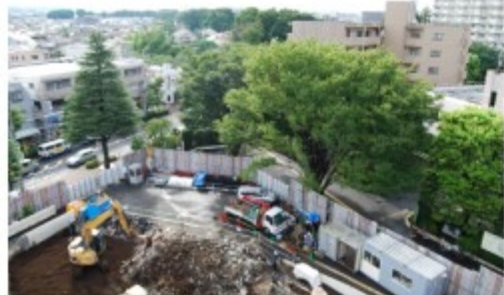
工事が始まった防災センター（手前）
